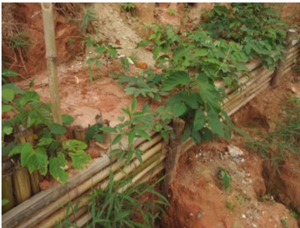
Figura 6: Paliçada de bambu instalada no interior da voçoroca. Foto: Tiago de A. Chaves
