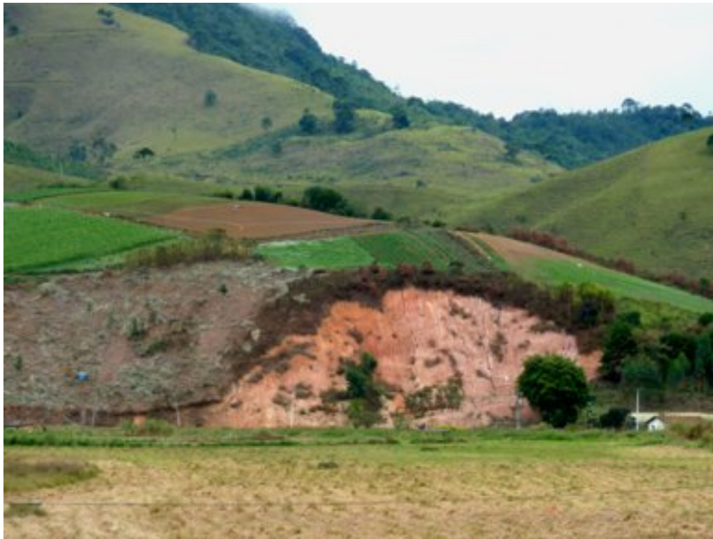
Figura 2: Erosão por deslizamento de terra. Foto: Tiago de A. Chaves
